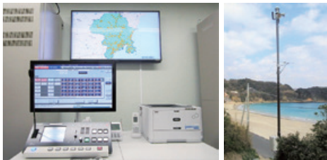
静岡県下田市様の防災行政無線システム操作卓 (左) 広域への音声伝達が可能なモーターサイレン装備の子局 (右)
