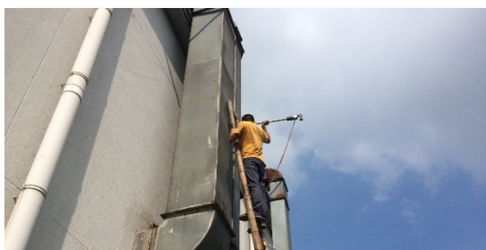
富士通將軍中央空調（無錫）におけるダクト点検の様子
