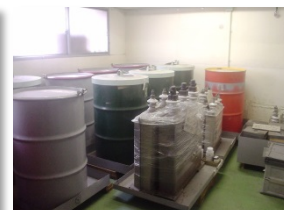
本社のポリ塩化ビフェニル保管倉庫内
