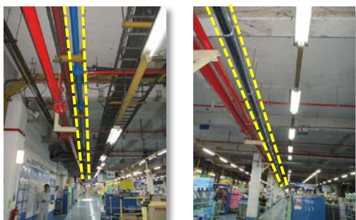
更新前（点線内：スチール管） 更新後（点線内：ポリエチレン管） FUJITSU GENERAL(THAILAND)の給水主管の更新
