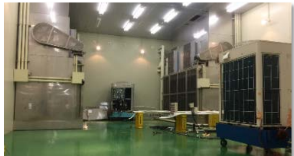
本社のエアコン評価試験室
