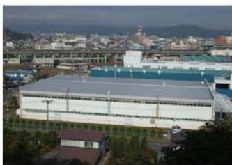
建屋断熱塗装 改善後
