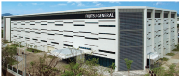
R&Dセンター外観 (3階建て延べ床面積約10,000㎡)
