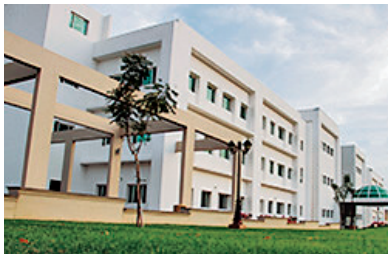
当社製VRFを納入した オマーンの学校
