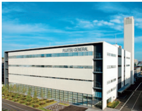
本社川崎事業所の空調技術棟と高低差試験塔
